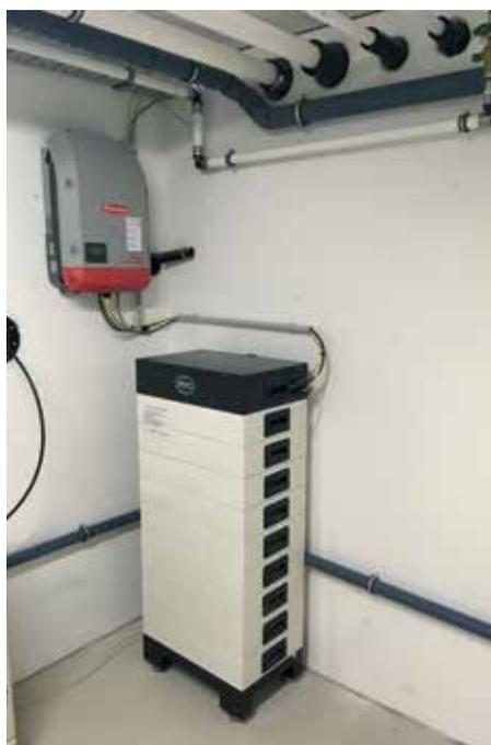
Die Batterie zur PV-Anlage speichert die Strommenge die nicht direkt gebraucht wird und gibt den Strom wieder ab, wenn im Haus mehr gebraucht wird als die PV-Anlage im selben Moment erzeugt. Es gilt aber auch hier: Wenn das öffentliche Netz ausfällt, dann erzeugt auch die PV-Anlage keinen Strom. Somit stellt auch eine Batterie-PV-Anlage per se keinen Blackout Schutz dar.
